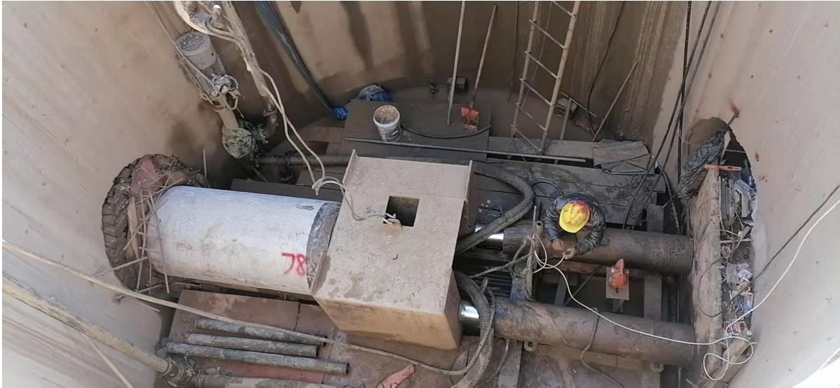
顶管施工
